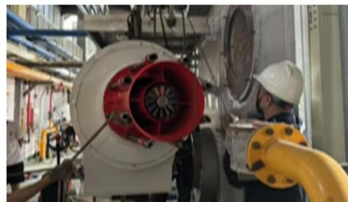
普宁公司对 4 台 20 吨锅炉进行水锅 FIR 内循环燃烧器改造，改造后颗粒物排放 < 10mg/Nm<sup>3</sup>、二氧化硫排放 < 35mg/Nm<sup>3</sup>、氮氧化物排放 < 30mg/Nm<sup>3</sup>
