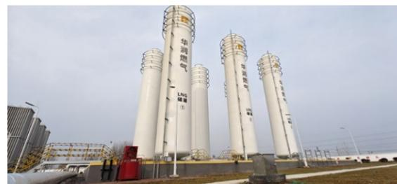
► 滕州公司顺利完成高铁新区综合门站建设，新建 6 个液化天然气 (LNG) 储罐和 8 套气化设备，新增储气能力 1200 立方米
