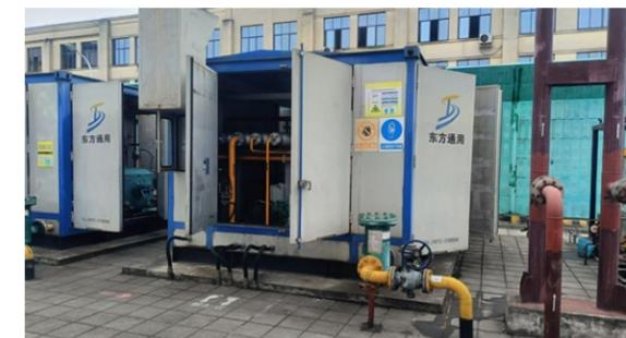
万科公司通过对城北客运中心汽车加气站的压缩机进行降噪处理，以减少噪声对员工听力的损害
